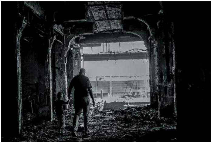
Anschlagsort im Stadtteil Karrada 2016
